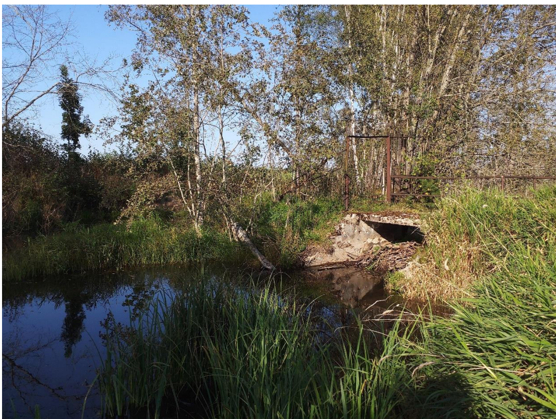
Joonis 4. Regulaator on täielikult ummistunud ega ole märke hoolduste teostamisest (4.09.24).
